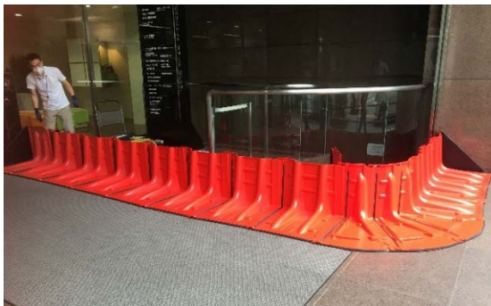
止水板「フロード・ガード」設置の様子
