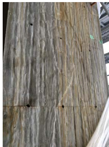
脱型後のコンクリート柱（現場写真）
