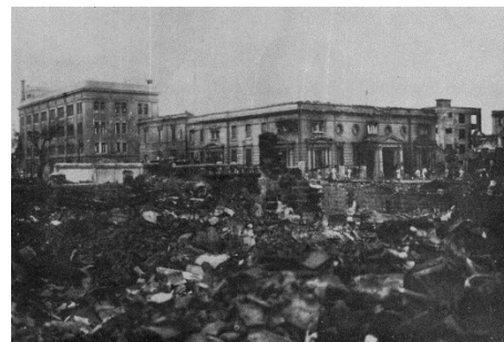
【関東大震災後の元第一国立銀行の建物】
