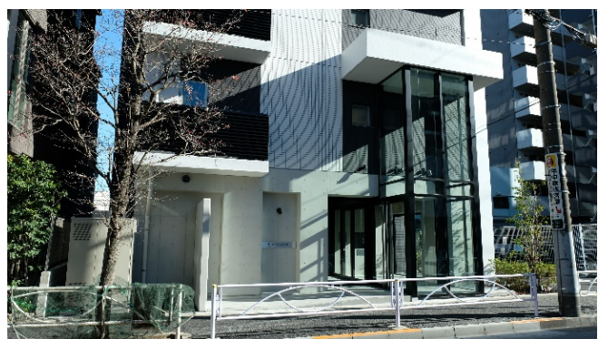
&lt;エントランス（外観）&gt;
