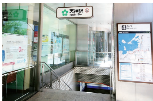
地下鉄出入口 天神駅出入口に直結し雨の日も快適にアクセス
