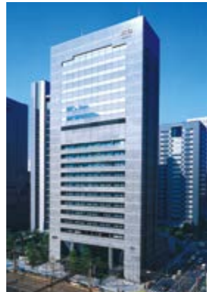
内幸町平和ビル (東京都千代田区)
