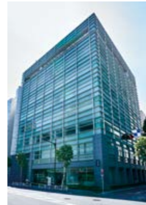
兜町第6平和ビル (東京都中央区)
