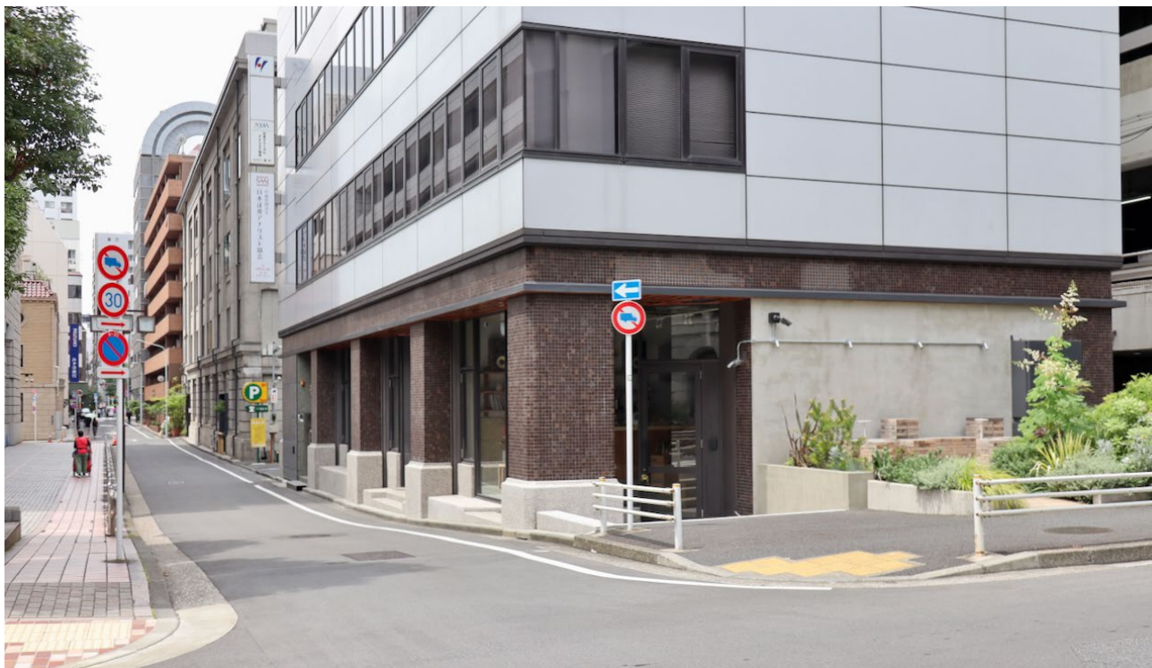
外装の石材は撤去し、創建時のモザイクタイルを表した。北側のオープンスペースと連続する滞留空間を創出した。
