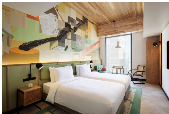
客室内の木柱や木梁を露出させるとともに、製材型枠を現し天井として利用し天井高さ約3.3mの開放感のある木空間を実現
