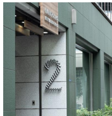
兜町第 2 平和ビル
