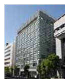
兜町第6平和ビル
