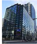
平和不動産桜通ビル
