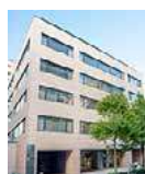
兜町第1平和ビル
