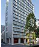
兜町第4平和ビル
