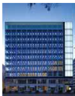
一番町平和ビル
