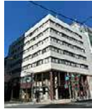
兜町第7平和ビル
