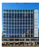
一番町平和ビル
