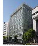
兜町第6平和ビル
