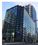
平和不動産桜通ビル
