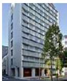
兜町第4平和ビル
