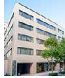
兜町第1平和ビル
