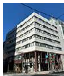
兜町第7平和ビル
