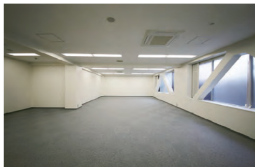
貸室 耐震補強工事実施済
