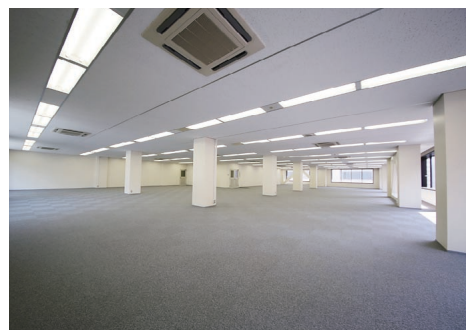
貸室 耐震補強工事実施済
